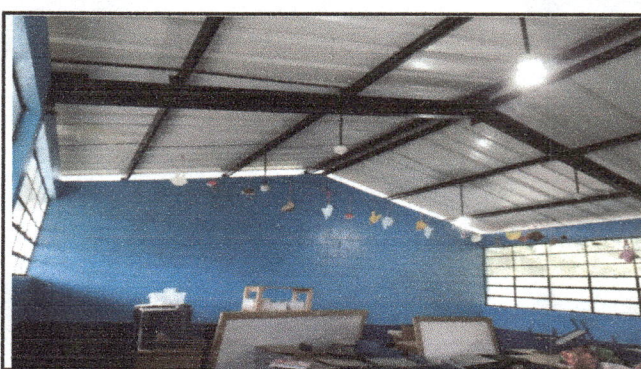
Foto 4: se observa la pintura en muros interiores e instalación eléctrica.
