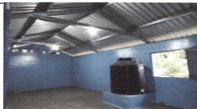
Foto 3: se observa que instalaron estructura de soporte y cubierta de lámina.
