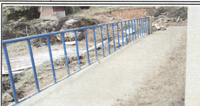
Foto 2: se visualiza las instalaciones de barandales
